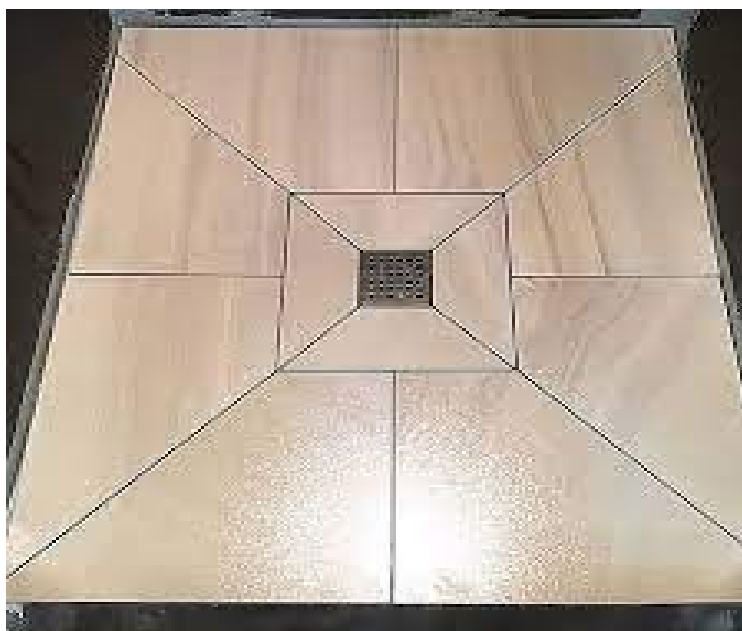
Figura 04 – Modelo de paginação sugerido para revestimento do piso de boxes com chuveiro, junto aos ralos de grelha quadrada ou retangular.
